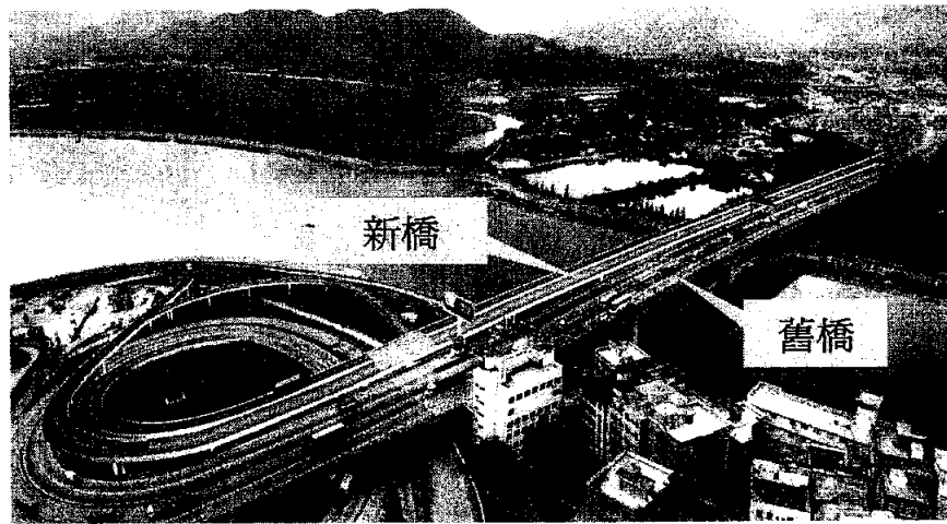
圖13 — 興建落馬洲至皇崗新跨界橋
