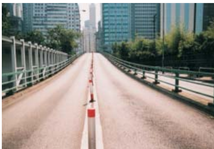
圖 9.2 - 第一代三杆鋼製 P1 護欄
