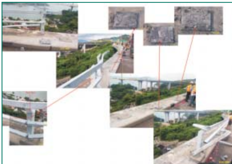
圖 3.8 – 損毀的護欄
