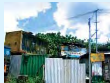
露天倉庫及鄉郊工業
