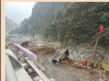
2012 年 11 月 (調整方案施工中)
