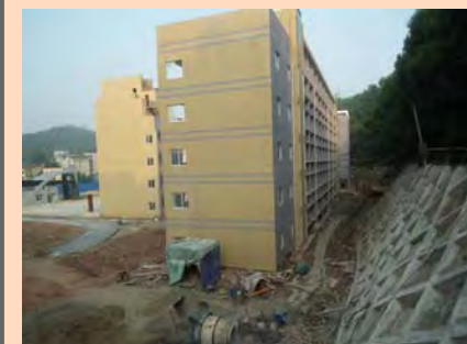
2012 年 11 月 (邊坡工程)
