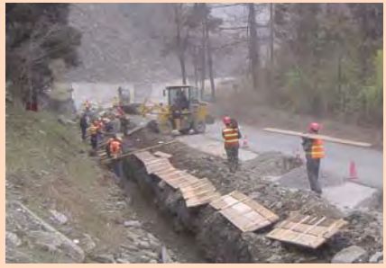
2011 年 3 月 (光纜敷設工程)
