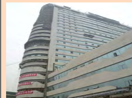
2012 年 11 月 (幕牆施工中)
