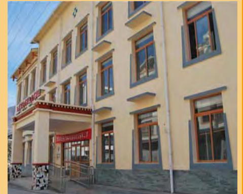
正門旁殘疾人坡道
