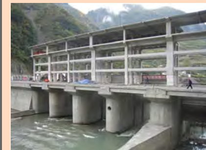
2012 年 10 月 (熊貓水電站)
