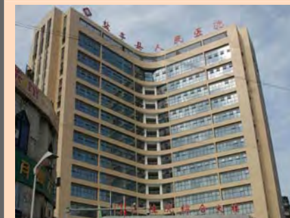
2012 年 11 月 (內裝及配套施工中)
