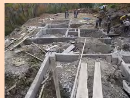
2012 年 11 月 (基礎工程)
