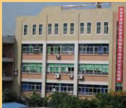
維修加固舊教學樓
