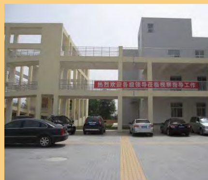
中心殘疾人坡道
