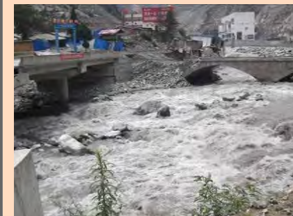
2011 年 7 月 (工地受破壞)
