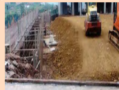
2012 年 11 月 (邊坡工程)
