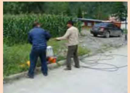
2011 年 10 月 (光纜敷設工程)
