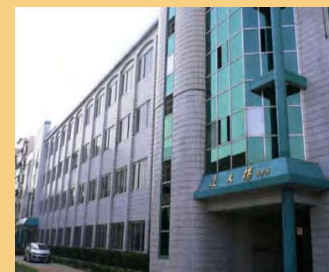
維修加固 (逸夫樓)
