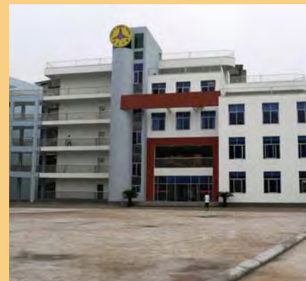
維修加固 (逸夫樓)
