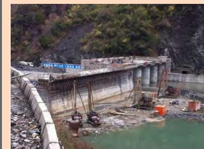
2012 年 4 月 (熊貓水電站)
