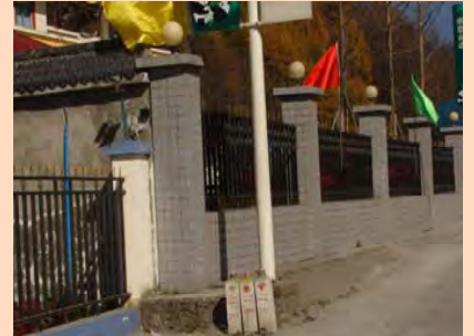
2012 年 11 月 (光纜敷設完成部份)
