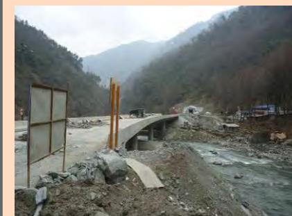
2012 年 3 月 (工地情況)
