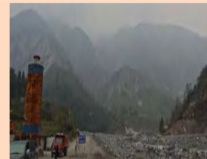
2012 年 11 月 (工地情況)
