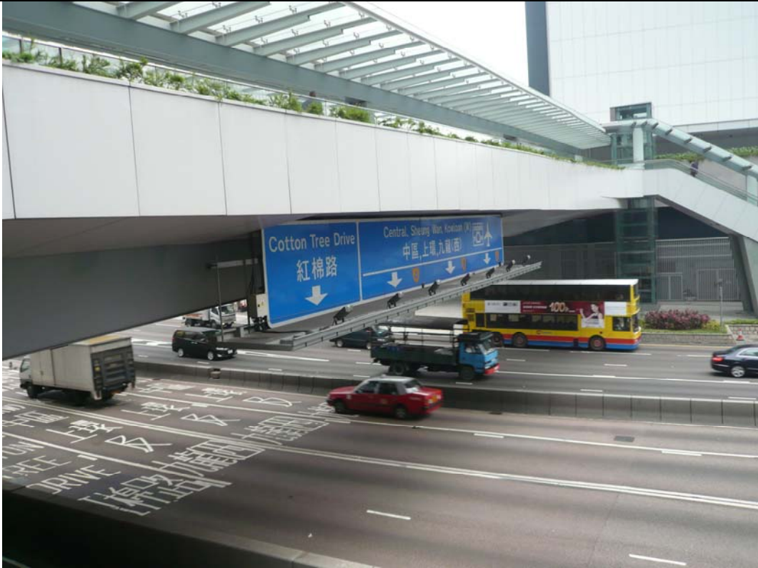
高架道路標誌照明
