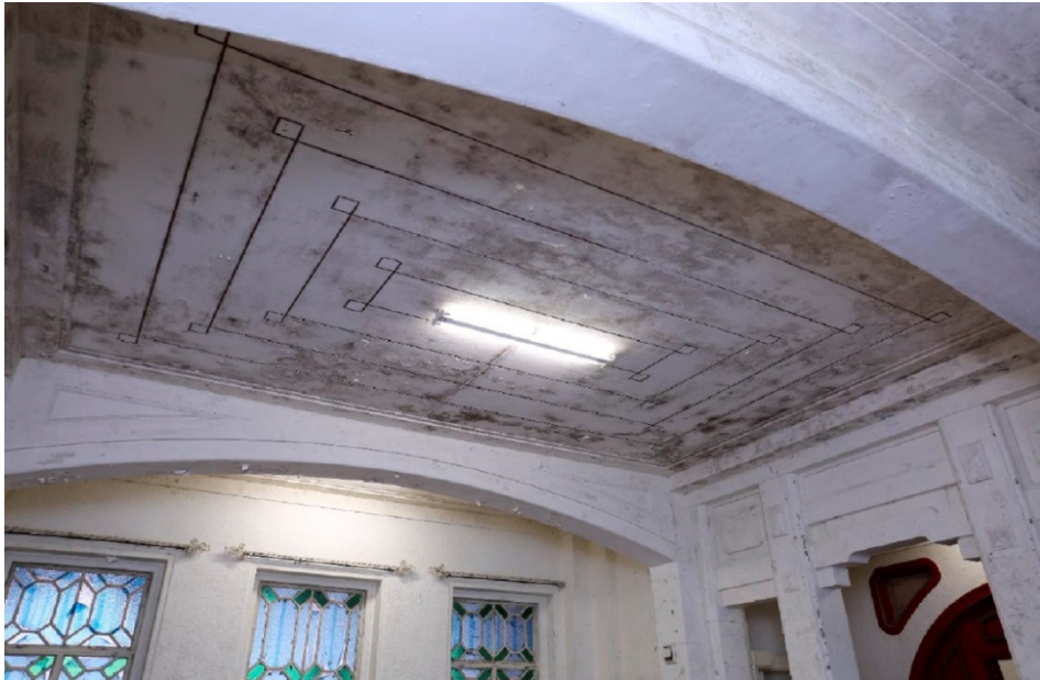
Ceiling of 1/F Hallway 一樓門廊天花
