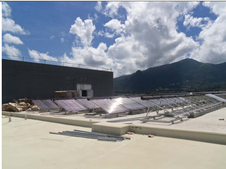
石崗大樓天台安裝太陽能板
