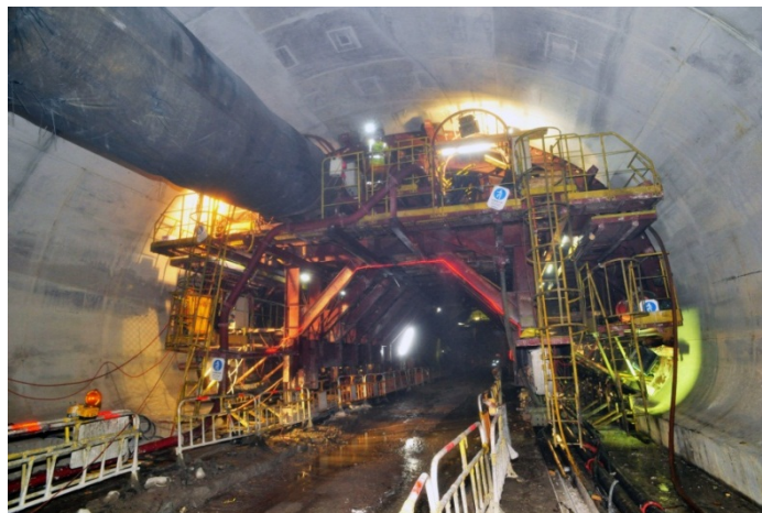
南風隧道隧道壁工程
