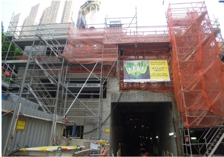
利東站 A 出入口結構工程
