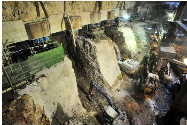
金鐘站港島綫隧道支撐架工程
