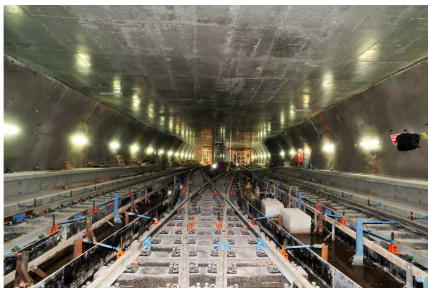
鴨脷洲隧道路軌鋪設工程
