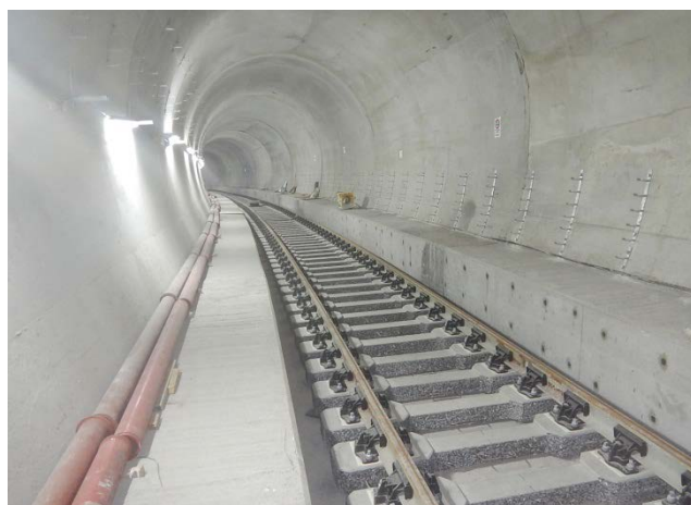
油麻地段路軌鋪砌工程
