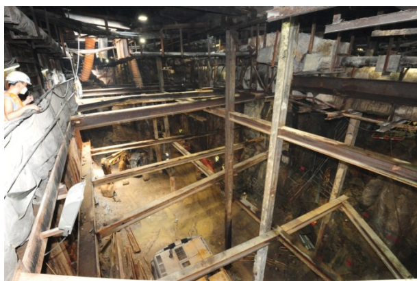
黃埔站的東、西大堂挖掘工程
