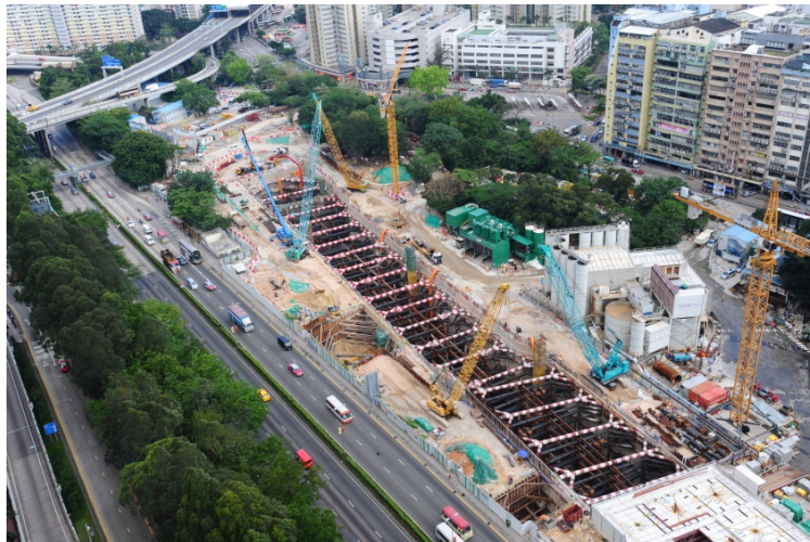
鑽石山站擴建工程
