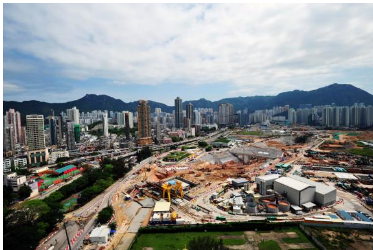
土瓜灣站工地
