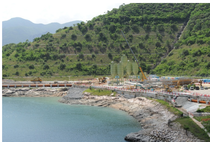
沉管隧道預製組件工場
