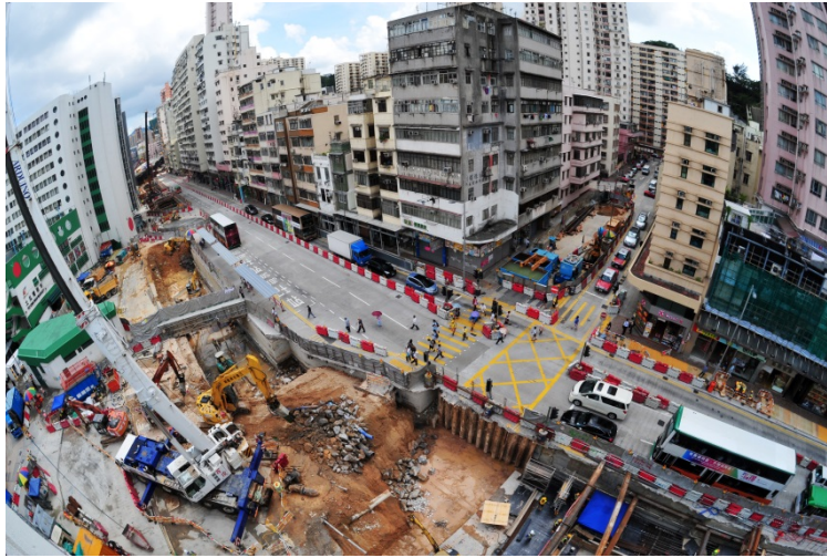
馬頭圍站工地
