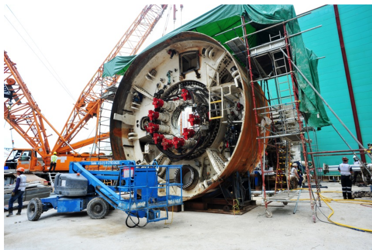
隧道鑽挖機於啟德工地重新組裝
