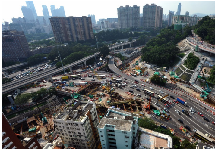
漆咸道北及溫思勞街旁的隧道挖掘工程
