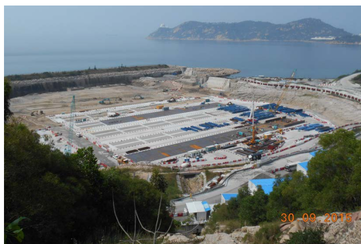
沉管隧道預製組件工場
