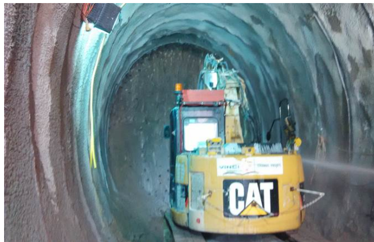
馬仔坑現正進行通風隧道挖掘工程
