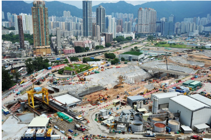
土瓜灣站工地
