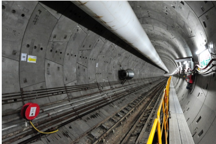
啟德至鑽石山下行綫隧道
