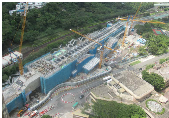
顯徑站及部分高架橋
