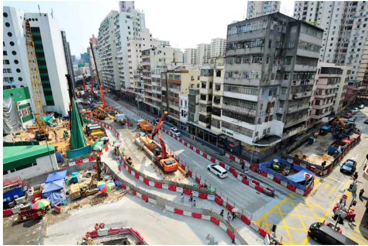
馬頭圍站工地
