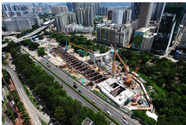
鑽石山站擴建工程
