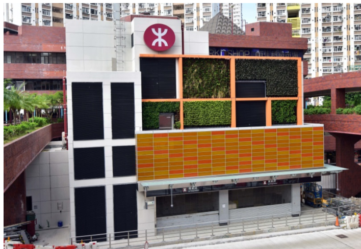
利東站的建造工程已完成
