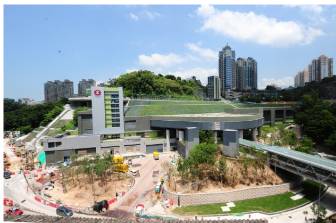
何文田站的裝修工程經已完成。
