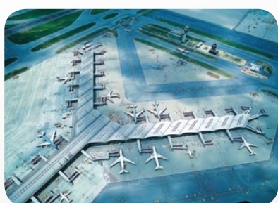
一號客運大樓西北客運廊啟用。
