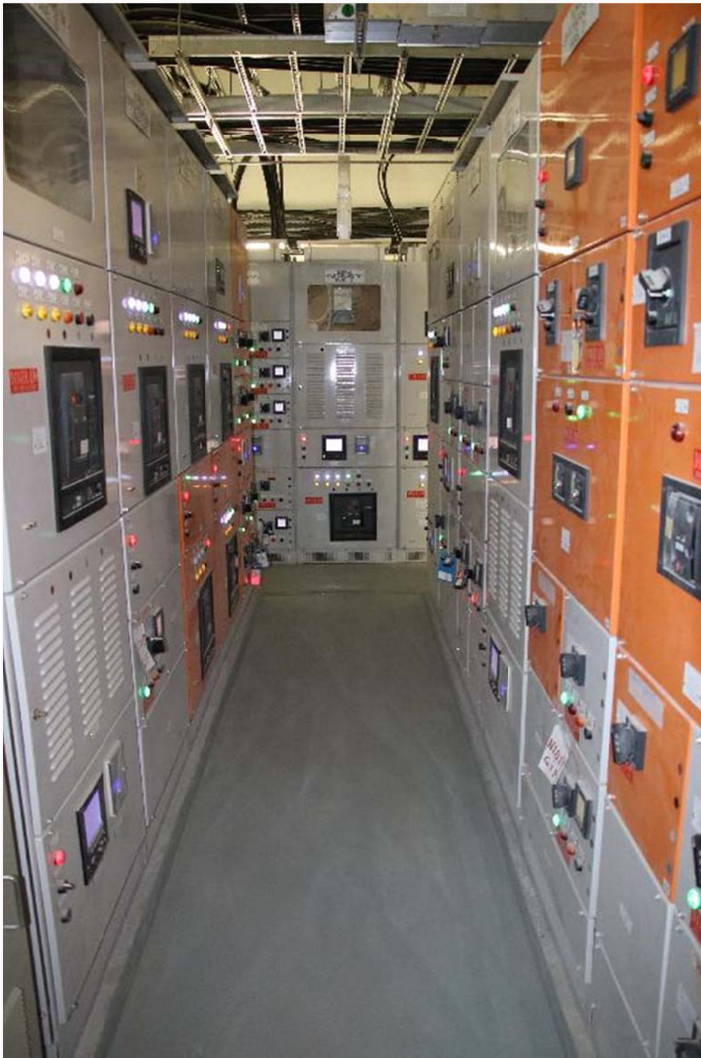
就港珠澳大橋香港口岸旅檢大樓地庫漏水事件，圖示二〇一八年四月十五日發生漏水事件有關位置現時的情況。
