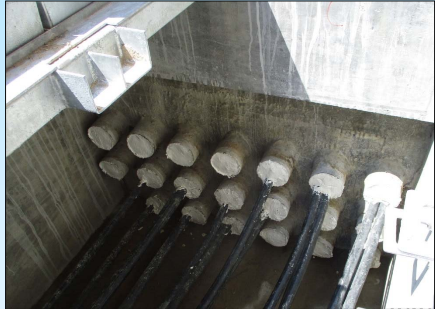
管道填封後情況
