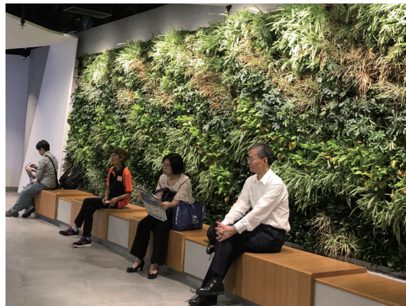
安裝於H6 CONET垂直綠化牆上的生物過濾系統，有助改善室內空氣質素。
