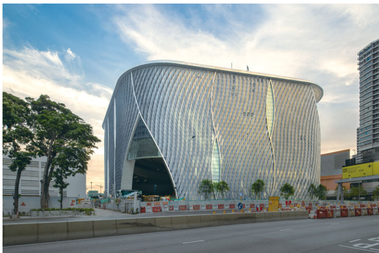
The Xiqu Centre nearing completion 戲曲中心接近完工
