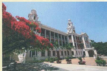
香港大學本部大樓外部 (法定古蹟)
