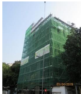
位於清譽街的升降機塔建造中
