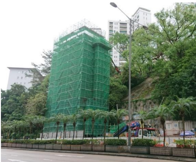
窩打老道山升降機塔建造中
