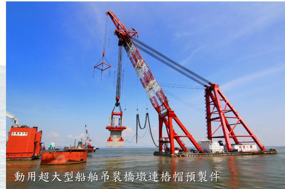
動用超大型船舶吊裝橋墩連樁帽預製件
