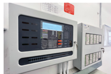
經改造重設的IB-2:SSP（左圖）新增多個消防系統，包括自動火警警報系統（右圖）、灑水系統及水缸（中圖）。
