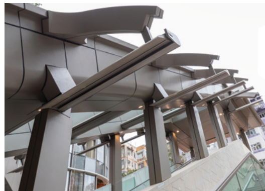
於裕民坊公共交通交匯處安裝的無扇葉通風裝置，有助改善空氣流通且減少耗電。
