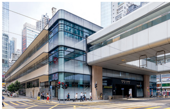
中環街市第二期工程竣工，新立面及扶手電梯進一步提升場地空間及易達性。
