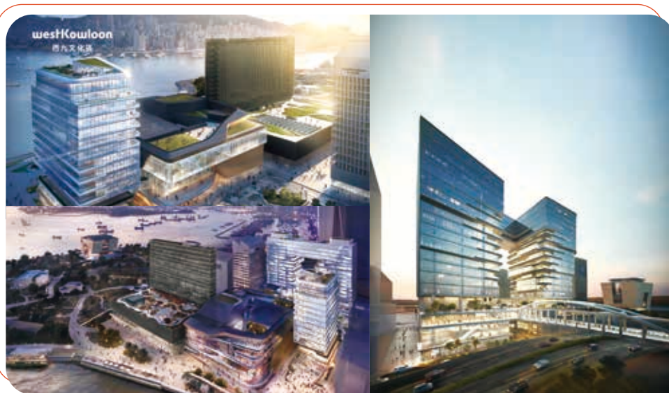
Digital rendering of the Artist Square Towers above the IB 將建於綜合地庫之上的藝術廣場大樓的數碼繪製圖
