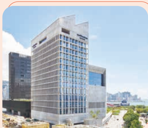
WKCDA Tower 西九文化區管理局大樓
