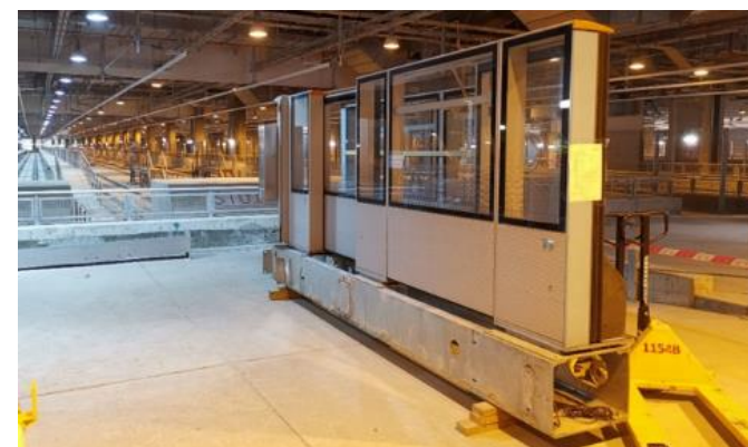
自動月台閘門安裝工程 Retrofitting of Automatic Platform Gates
