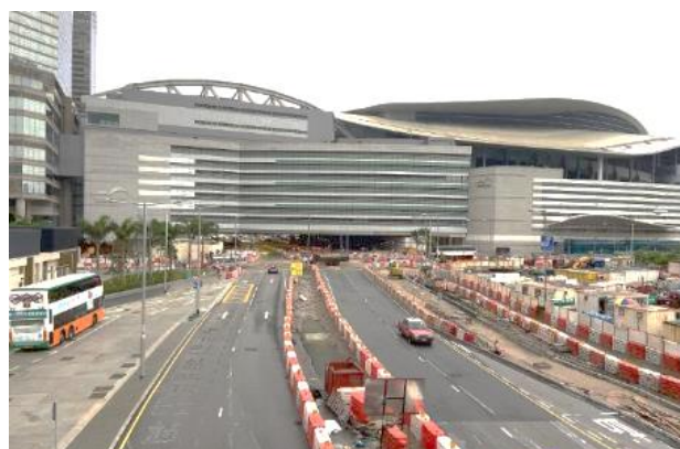
灣仔北道路改善工程 Road works at Wan Chai North
