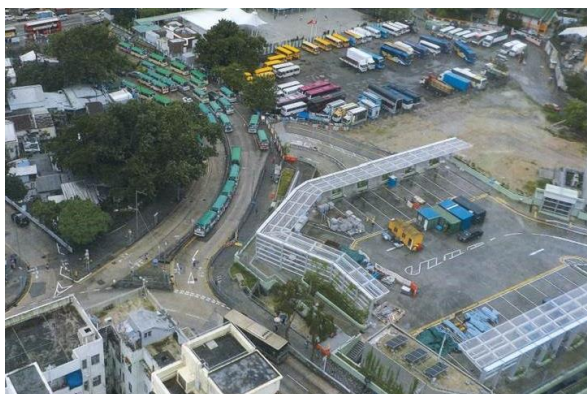
沙田坳道道路工程 Road reinstatement of Shatin Pass Road
