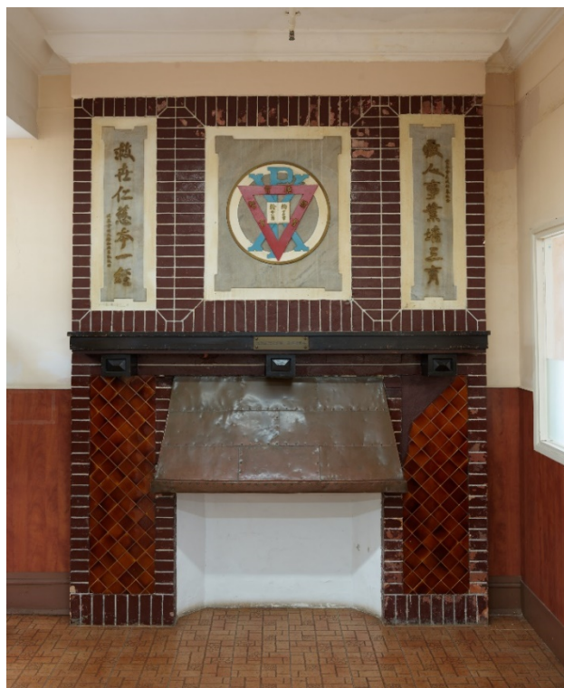
位於大樓地下的壁爐， 爐架上方的雲石板上有基督教青年會會徽和對聯。
