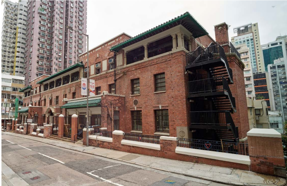
大樓正立面的托斯卡納式圓柱和綠色琉璃瓦屋簷
