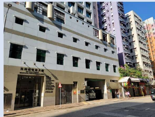
深水埗 - 元州街垃圾站
