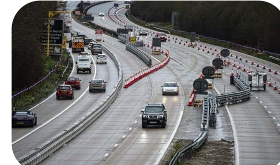
可變逆向車道
