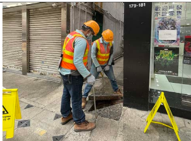
在後巷進行污水渠錯駁調查，透過加入色水追縱污染源。
