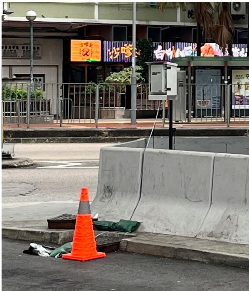
在雨水沙井試驗加裝氣味監測儀器輔助監察攝錄系統。
