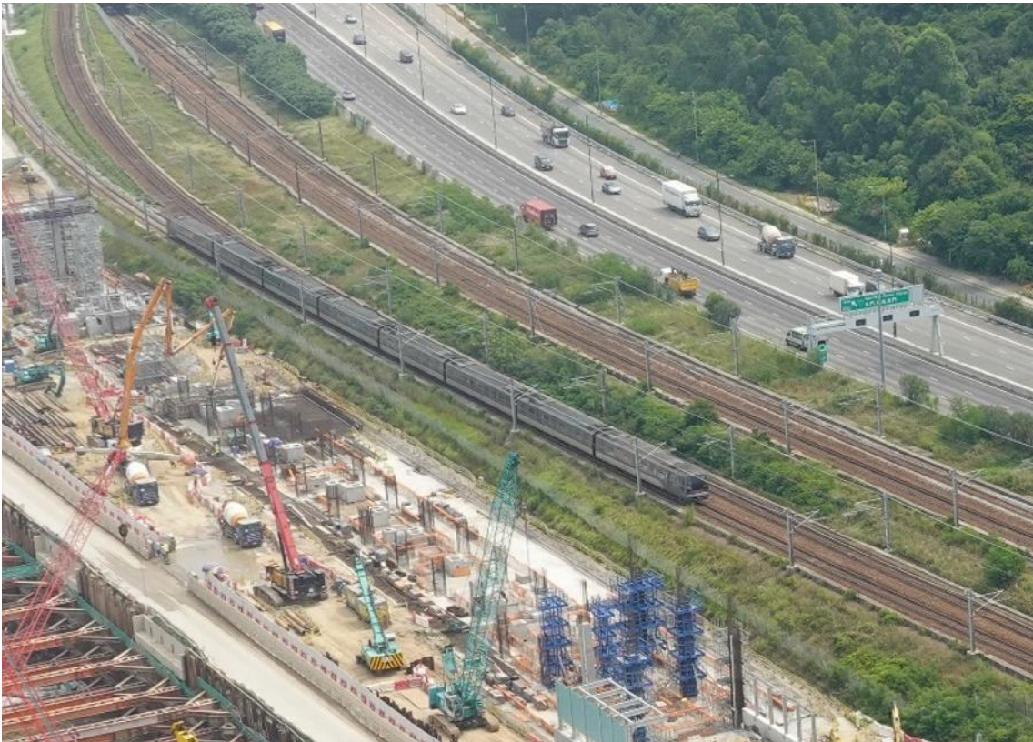
東涌東站施工進展
