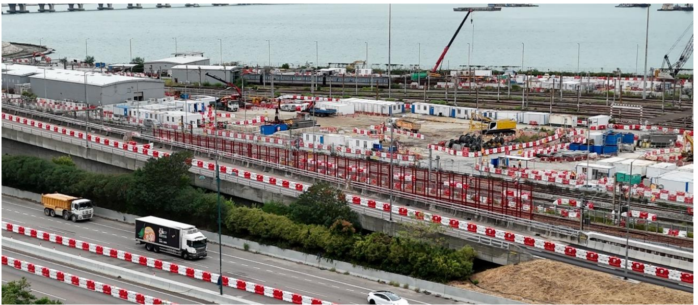
小蠔灣站施工進展
