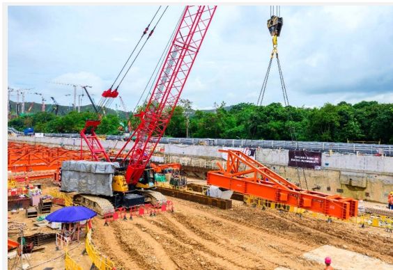
東鐵綫古洞站 - 大型挖掘工程 Kwu Tung Station on East Rail Line – bulk excavation
