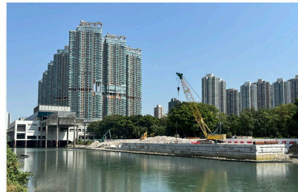
屯門南延綫 - 高架橋相關工程 Tuen Mun South Extension – viaduct related works
