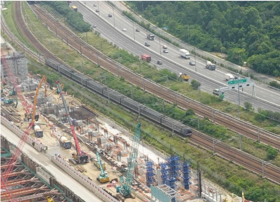
東涌東站施工進展
