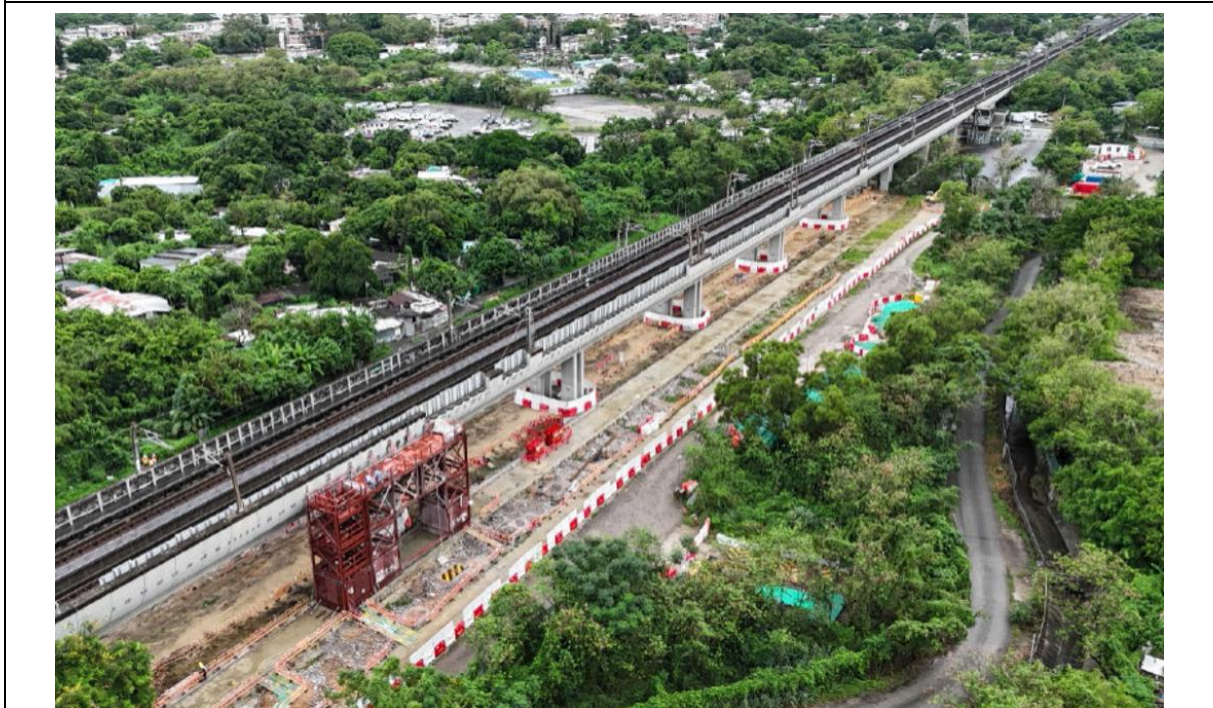
洪水橋站：正進行車站的前期工程
